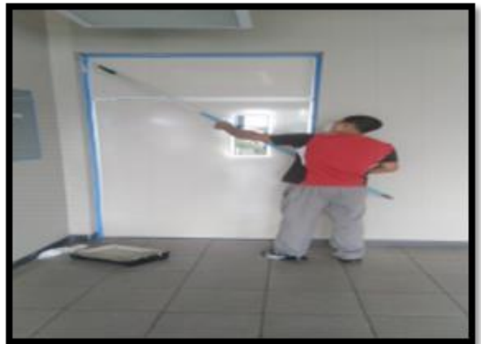
Imagen 15. Pintado de aulas Nivel 1
