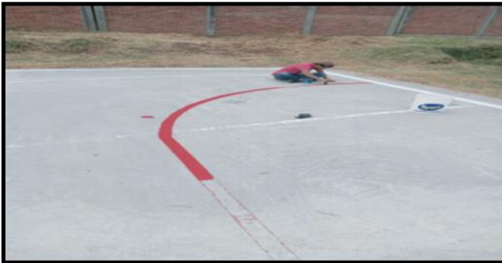
Imagen 19. Se pintan todas las líneas de la cancha de usos múltiples para practicar deportes como el basquetbol, futbol y voleibol.
