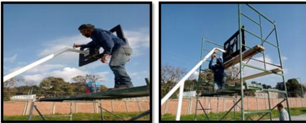
Imagen 18. Se hace cambio de los tableros de basquetbol y se pintan las bases de estos.
