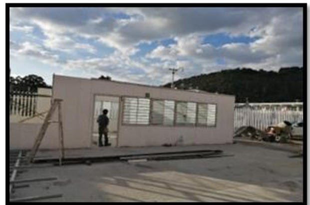
Imagen 13. traslado de las aulas prefabricadas en nueva ubicación
