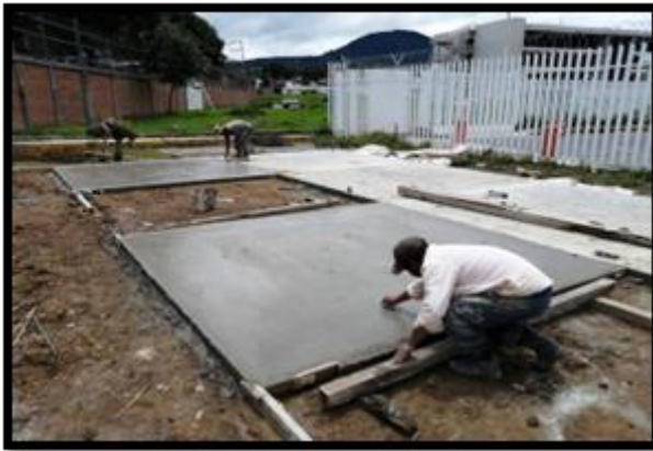
Imagen 12. los trabajos de mantenimiento y remodelaciones
